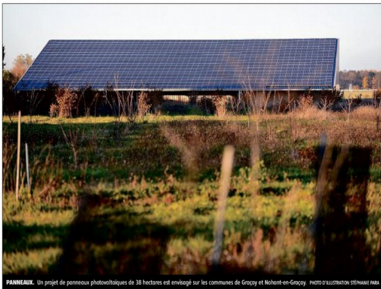
PANNEAUX. Un projet de panneaux photovoltaïques de 38 hectares est envisagé sur les communes de Graçay et Nohant-en-Graçay. PHOTO D'ILLUSTRATION STÉPHANIE PARRA
